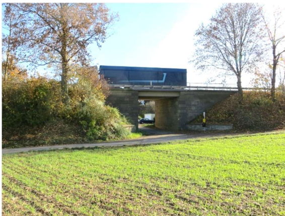
Bild 3: Unterführung der B 35
