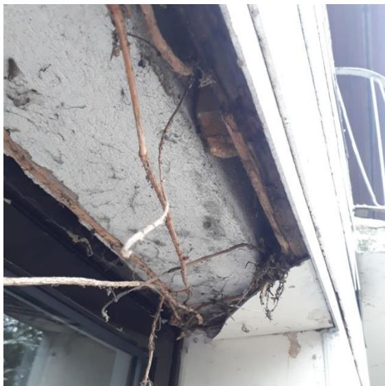
Abbildung 4: Spalten an Rollladenkästen können von Fledermäusen als Quartiere genutzt werden
