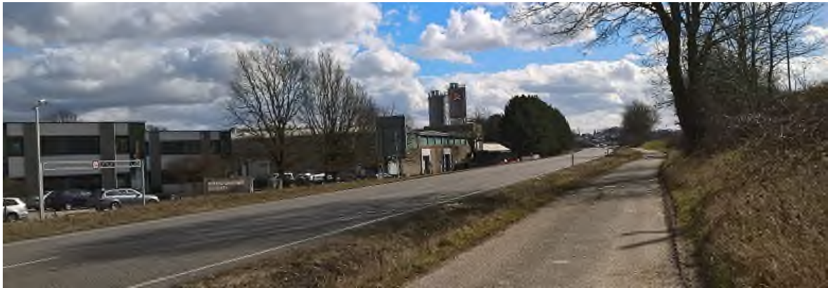
Bild 7: Ansicht von Nordwesten entlang B 35
